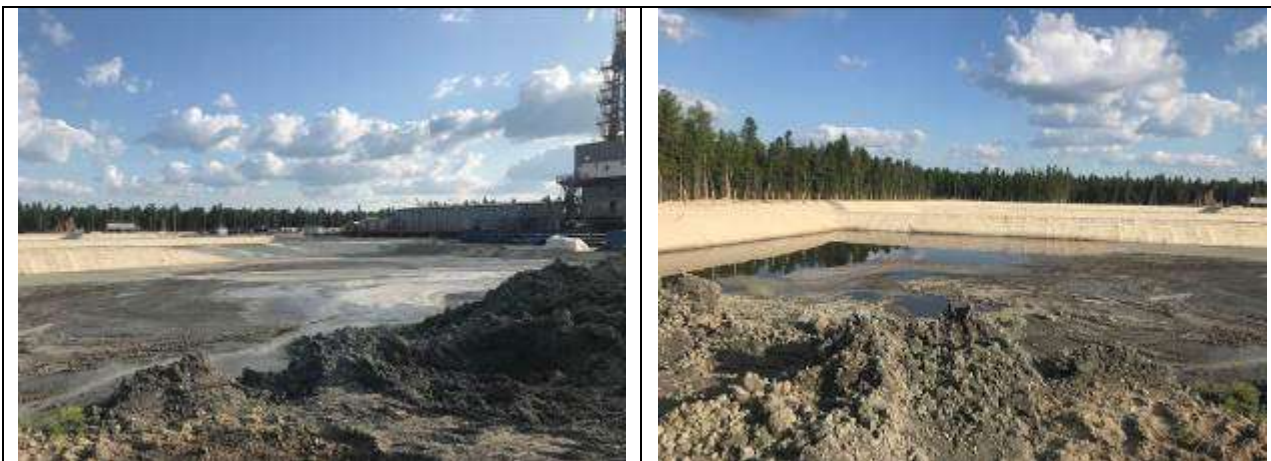
Место накопления отходов
